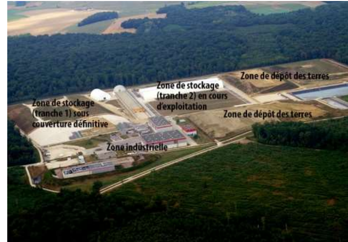
CIRES bei Morvilliers, 46 ha, Einlagerung 30.000 t pro Jahr
